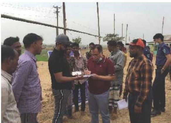
চিত্র-৫: জনাব মোঃ মাক্ক মিয়া, মহাপরিচালক (অতিরিক্ত সচিব), বাংলাদেশ হাওর ও জলাভূমি উন্নয়ন অধিদপ্তর কর্তৃক সুনামগঞ্জ জেলার বিষ্ণুপুর উপজেলার হাওর এলাকার বন্যা নিয়ন্ত্রণ বাঁধ পুনঃনির্মাণ কার্যক্রম পরিদর্শন।
