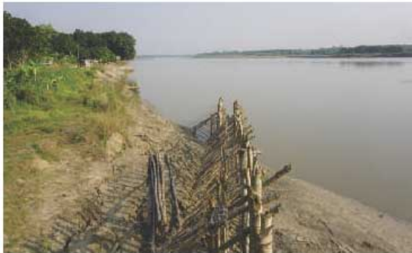
বাশিয়ারাকান্দির নারঙ্গা ঘাটের নিকট গড়াই নদীতে ভাঙন প্রতিরোধ এবং জিও ব্যাপের কার্যকারিতা নিশ্চিতকরণ
