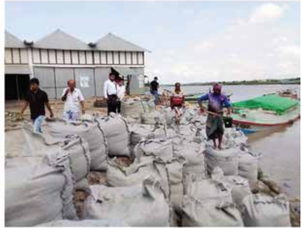
পদ্মা নদীর বাম তীরের ভাঙ্গন হতে দিঘীরপাড় বাজার ও ডহুরী গ্রাম রক্ষার্থে জরুরী অস্থায়ী প্রতিরক্ষামূলক কাজ, টংগিবাড়ী ও লৌহজং, মুন্সীগঞ্জ।
