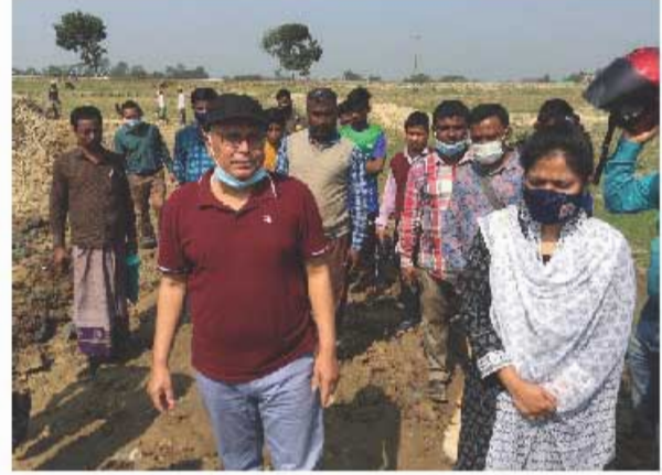
চিত্র-৮: জনাব মোঃ মাতক মিয়া, মহাপরিচালক (অতিরিক্ত সচিব), বাংলাদেশ হাওর ও জলাভূমি উন্নয়ন অধিদপ্তর কর্তৃক সুনামগঞ্জ জেলার সোয়ায়াজার উপজেলার হাওর এলাকার বন্যা নিয়ন্ত্রণ বাঁধ পুনর্নির্মাণ কার্যক্রম পরিদর্শন।
