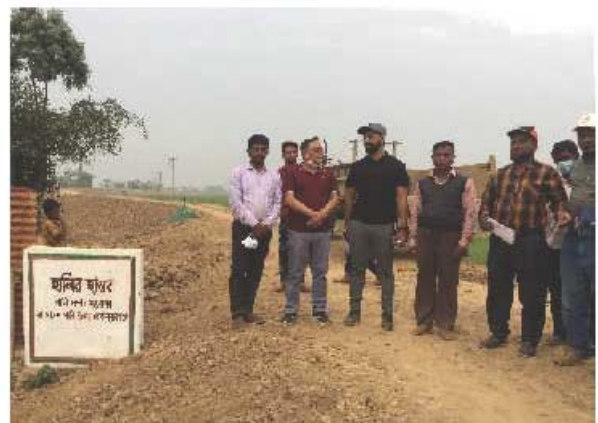
চিত্র-৬: জনাব মোঃ মাক্ক মিয়া, মহাপরিচালক (অতিরিক্ত সচিব), বাংলাদেশ হাওর ও জলাভূমি উন্নয়ন অধিদপ্তর কর্তৃক সুনামগঞ্জ জেলার বিষ্ণুপুর উপজেলার হাওর এলাকার বন্যা নিয়ন্ত্রণ বাঁধ পুনঃনির্মাণ কার্যক্রম পরিদর্শন।
